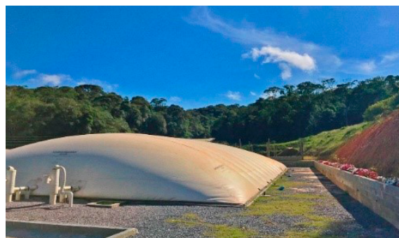
Figuras 5 e 6 - Biodigestão anaeróbia em uma granja comercial de suínos de ciclo completo do estado de São Paulo.
